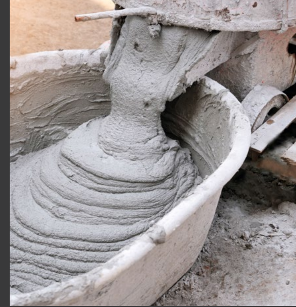
Einer der großen Treibhausgasemittenten ist Beton.
